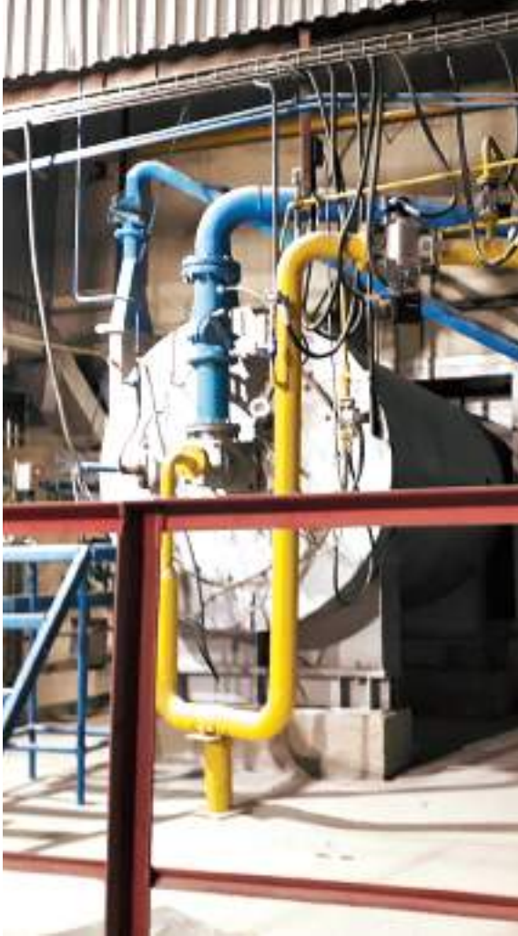
Технологический процесс в НКЗ полностью автоматизирован
