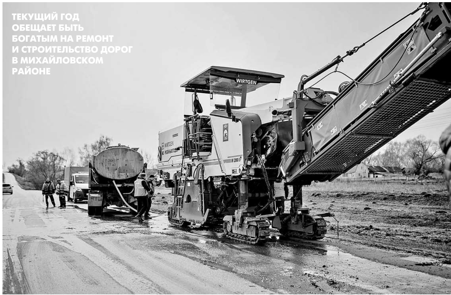
Укладку асфальта в селе Прудская ведет Михайловское ДРСУ
