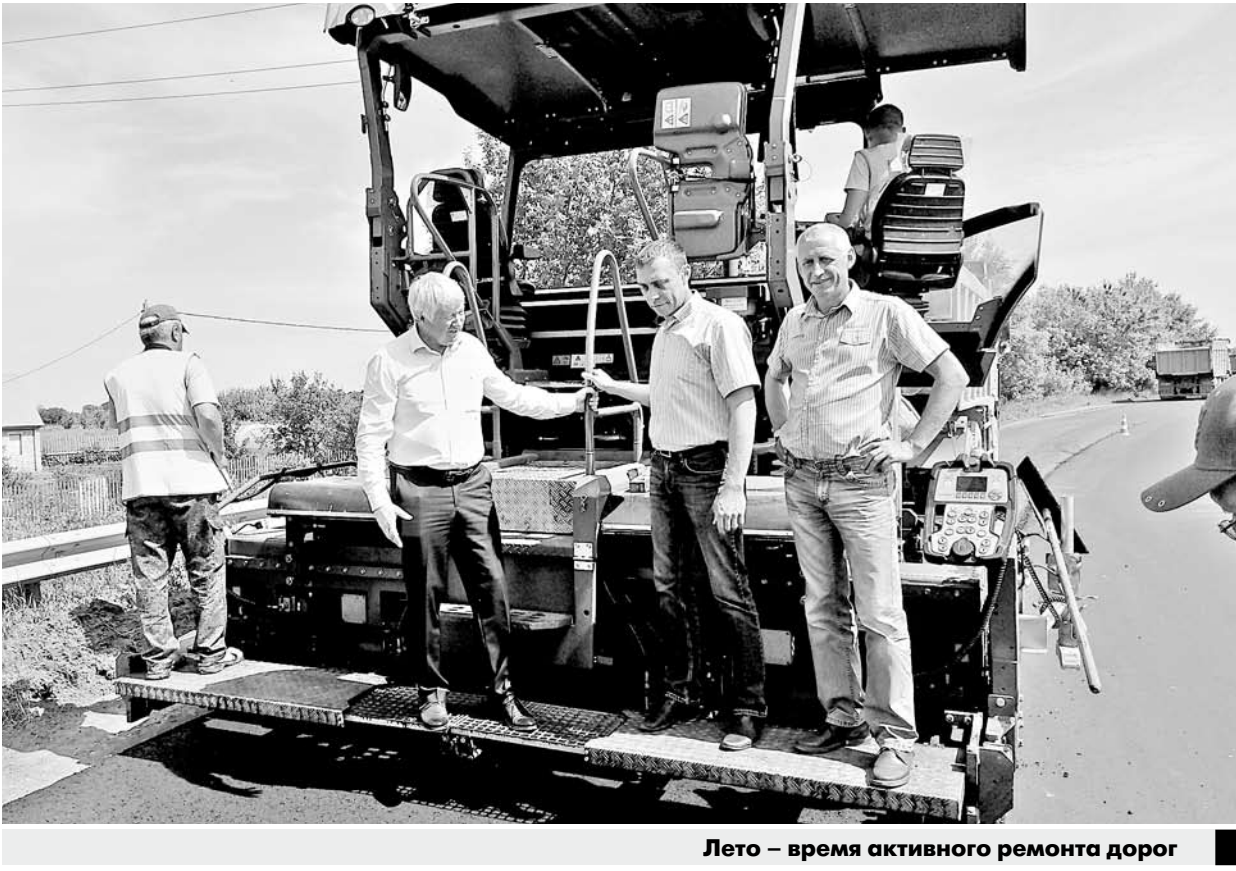
Лето – время активного ремонта дорог
