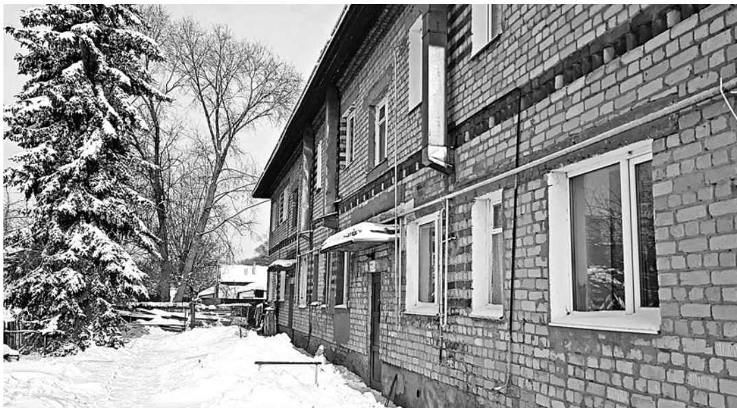
Одна из двухэтажек по улице Советской, жители которой рассчитывают уже в этом году на подключение к сети городской канализации
