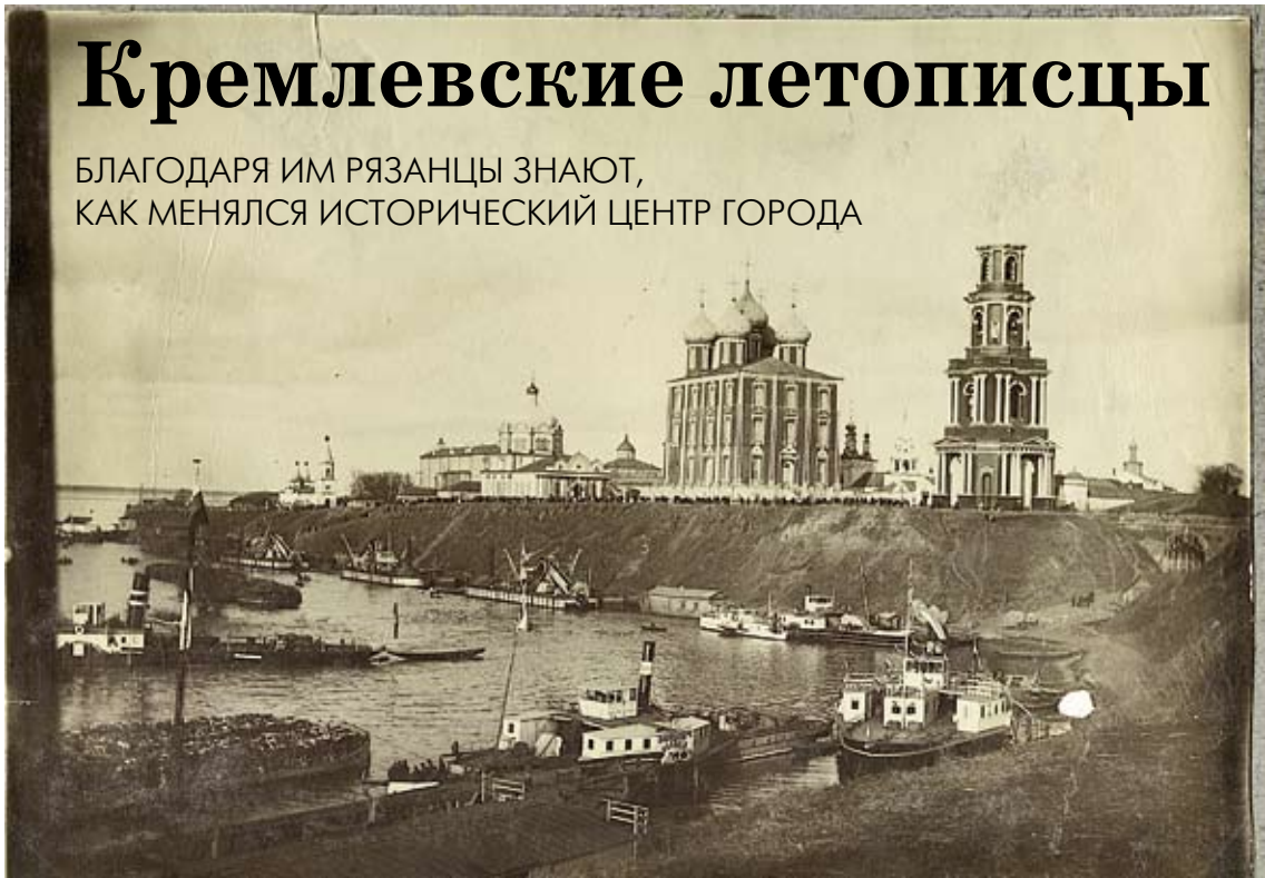
Кремлевские летописцы БЛАГОДАРИМ ИМ РЯЗАНЦЫ ЗНАЮТ, КАК МЕНЯЛСЯ ИСТОРИЧЕСКИЙ ЦЕНТР ГОРОДА Панорама Рязанского кремля во время разлива. Глебовский мост в строительных лесах. На склоне берега для его укрепления установлены деревянные конструкции, вдоль набережной проходит деревянное ограждение. На Трубеже множество судов: пароходы, катера, груженные дровами баржи, лодки. К северному склону кремля пришвартованы баржи-погрузчики с лебедками и транспортерами. На переднем плане пароход «Александр Невский». 1904–1910 гг. Неизвестный фотограф
