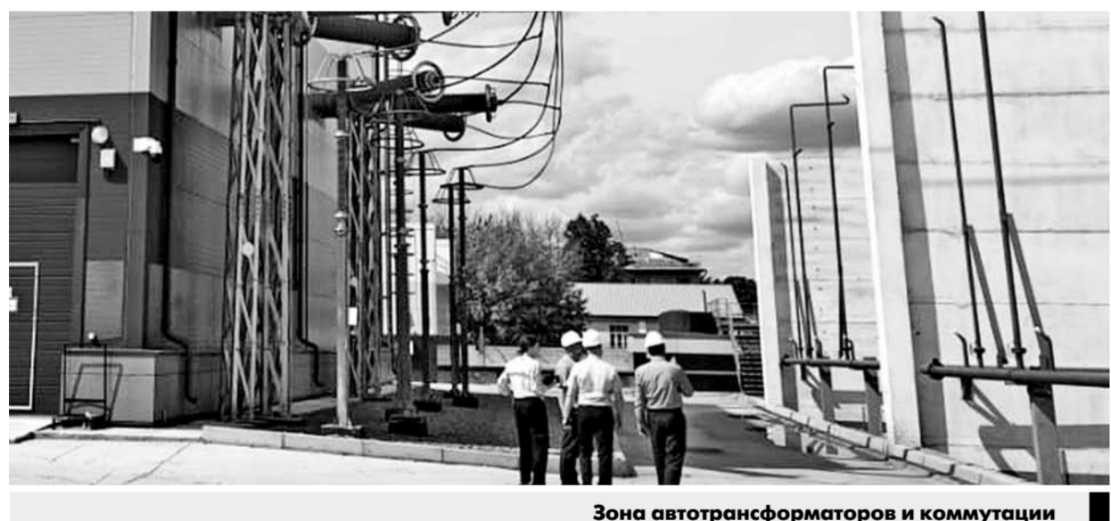
Зона автотрансформаторов и коммутации
