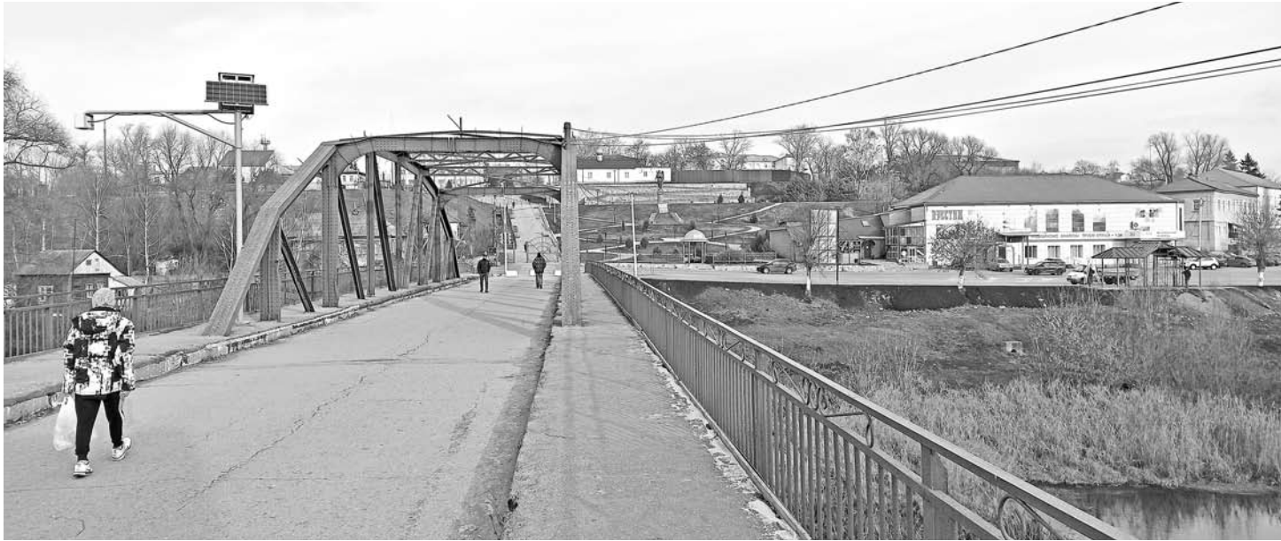
В следующем году под старинным мостом через Прону планируют обустроить набережную
