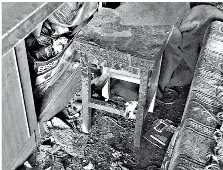
Сейчас дождевая вода смывает с потолка сажу
