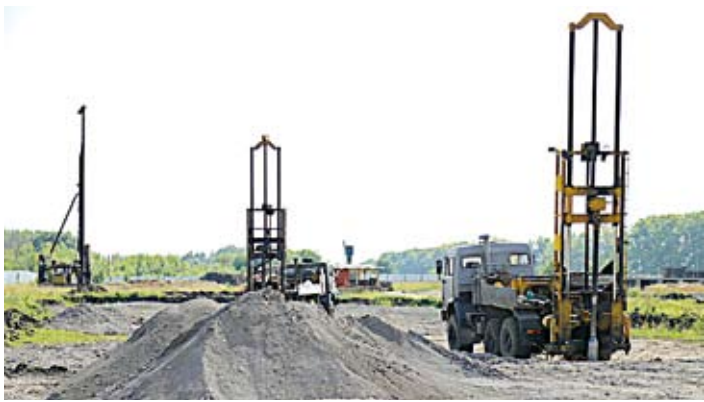
Строительная площадка ЗАО «Победа». Скоро здесь будет одно из самых крупных зернохранилищ региона
