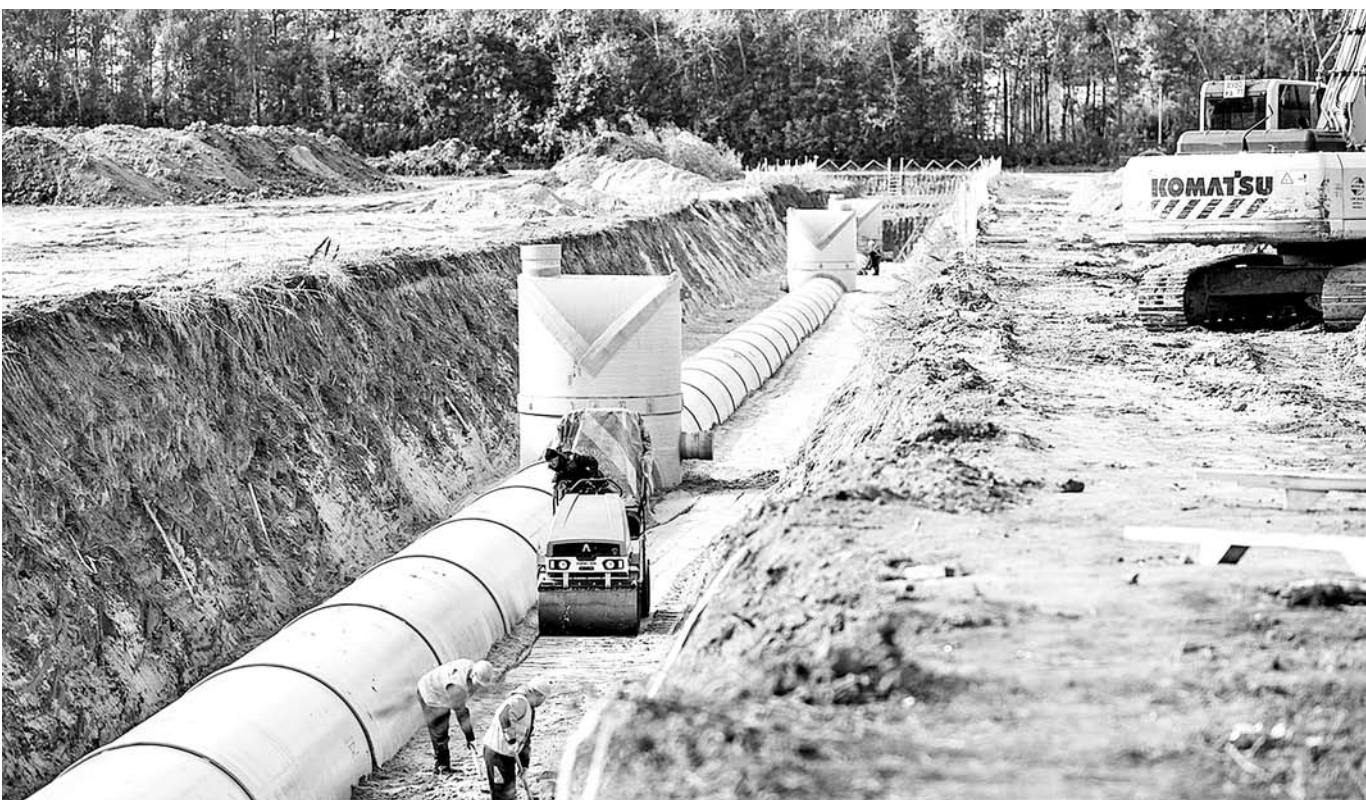
Индустриальный парк «Рязанский». В настоящее время это одна из крупнейших инвестиционных площадок региона, и вопросу технического подключения новых производств здесь уделяют повышенное внимание, обеспечивая беспрецедентную скорость работы
