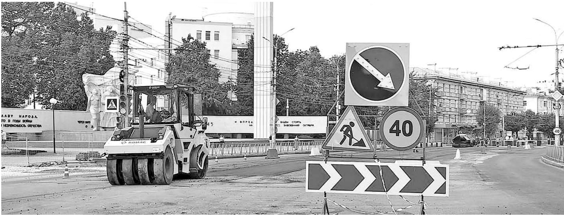
На этой неделе завершается первый и начинается второй этап ремонта сетей под Первомайским проспектом. В этом году подрядчики работают сообща — график работ согласуют заранее
