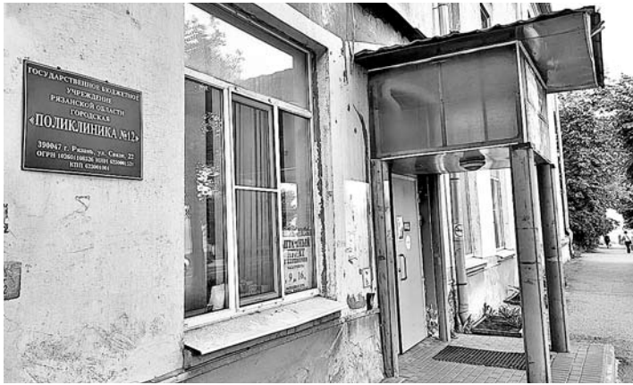
Нынешнее состояние поликлиники № 12
