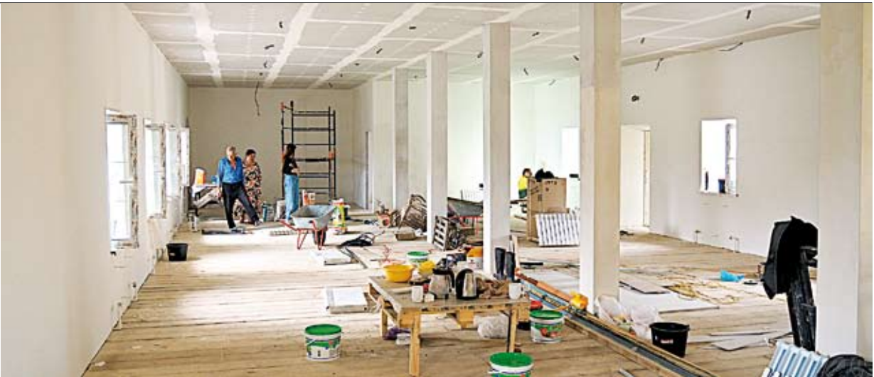
В здании будущего музея идут отделочные работы
