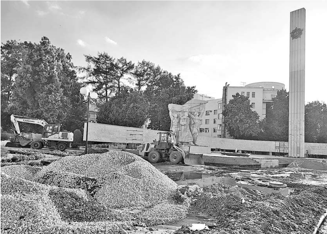
Ремонтные работы на площади Победы
